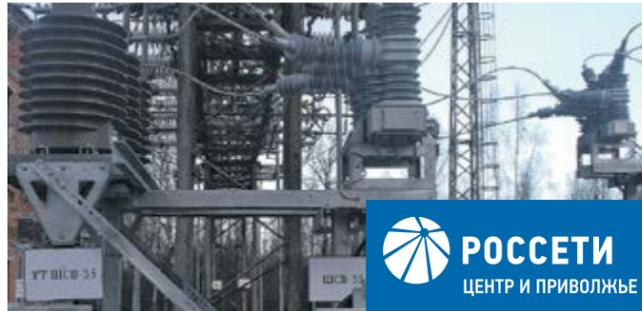
С 110 кВ «Середейск» имеет важное значение для перетоков мощности между узлами сети энергосистемы Калужской области и соседних регионов, также это один из ключевых питающих центров Сухиничского района. В ходе реконструкции восемь масляных выключателей были заменены на цифровые программно-аппаратные комплексы
