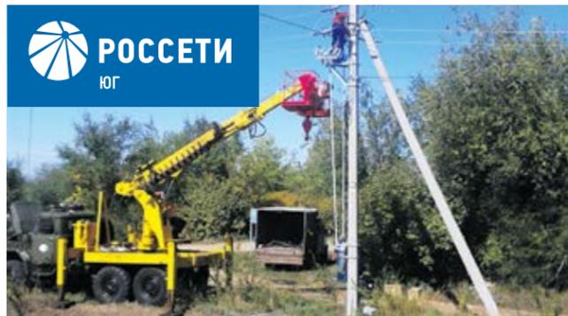
Установка реклоузеров на опоры ВЛ 6–10 кВ в Камышинском РЭС
