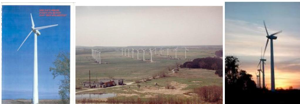
На Зеленоградской ВЭС установлены: 1 ветроустановка ВГ 01 типа Wind World 4200/600 мощностью 0,6 МВт; 20 ветроустановок (ВГ 02 - ВГ 21) типа Vestas V27/225 мощностью по 0,225 МВт каждая. По состоянию на конец 2011 года 7 ветроустановок находятся в ремонте.
