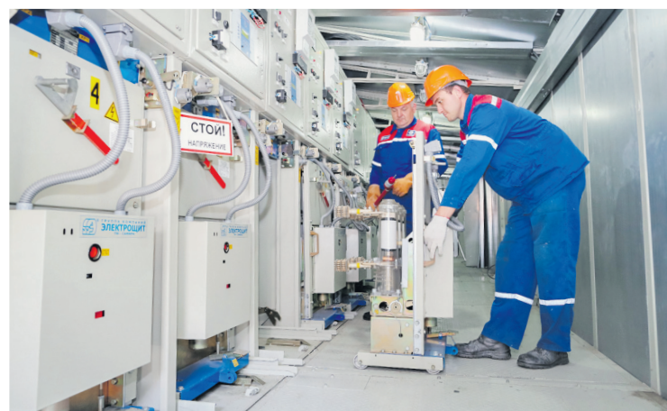
Электромонтеры филиала Севкавказэнерго Сергей Моргоев и Владимир Коломыц вводят в работу выкатной элемент вакуумного выключателя ячейки 6 кВ на ПС 110 кВ «Городская»
