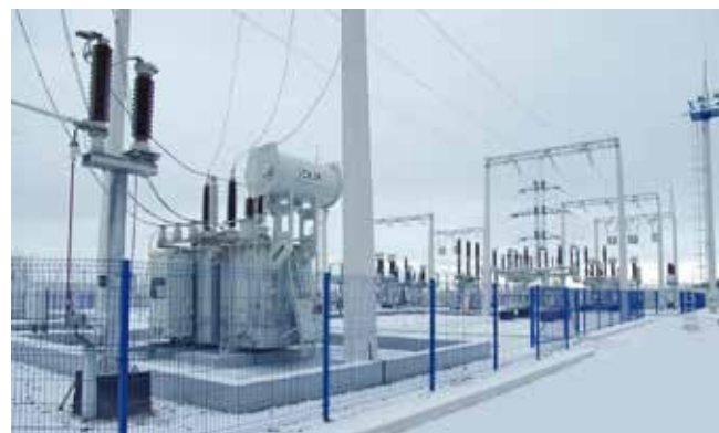
Завершение основных мероприятий по реконструкции подстанций 110 кВ «Ладушкин», «Славск», «Полесск», «Багратионовск», «Озерки»
