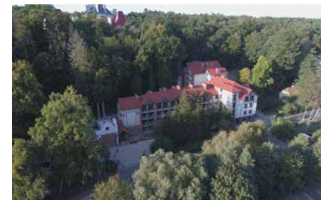
Завершение реконструкции санатория-профилактория «Энергетик»
