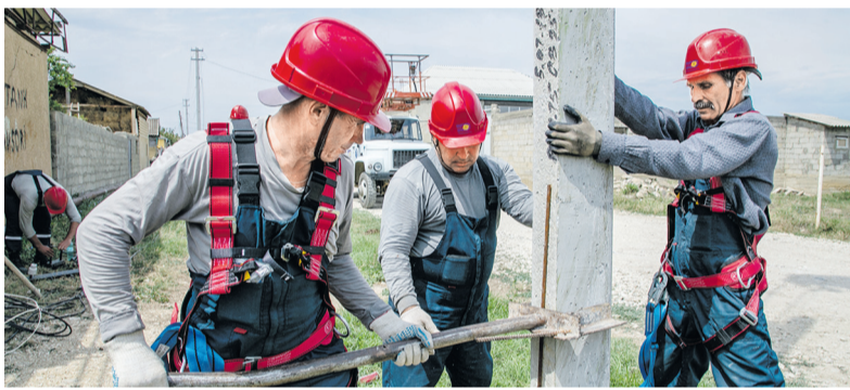
Члены бригады филиала Кубаньэнерго — Юго-Западные электрические сети устанавливают новые опоры ВЛ в селе Новый Кумух в Буйнакском районе Дагестана
