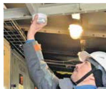
Для дистанционного контроля параметров состояния электросетевых объектов смонтированы специальные датчики
