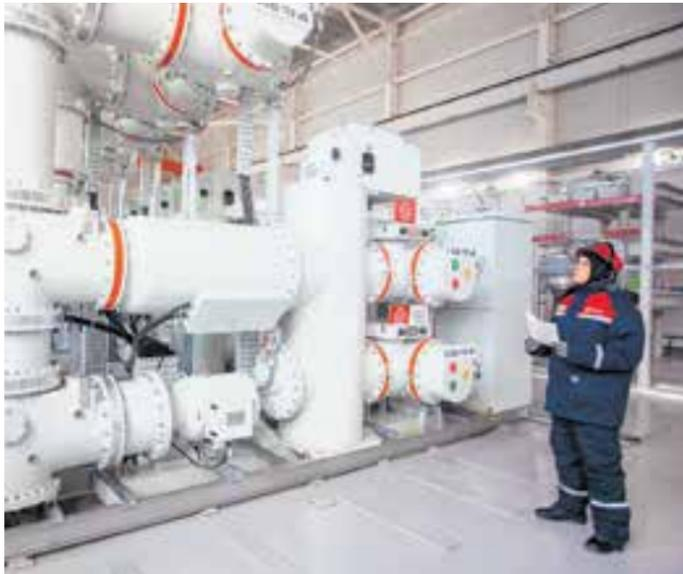
**П**С «Порт» — подстанция закрытого типа с использованием самого современного высокотехнологичного электрооборудования и цифровых технологий. Преимущества такого типа ПС — в их высокой степени надежности, длительном сроке эксплуатации оборудования, защите от гололедообразования и ветровых нагрузок, что немаловажно в сложной климатической зоне Таманского полуострова. Сейсмостойчивость подстанции составляет 8 баллов, энергообъект обладает повышенной безопасностью для окружающих и животного мира.
